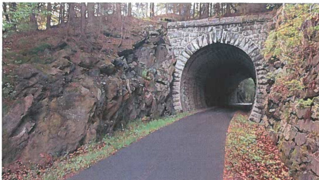
Fot. Droga dla rowerów zrealizowana wzdłuż przebiegu dawnej linii kolejowej Jáchymov - Ostrov, Czechy
