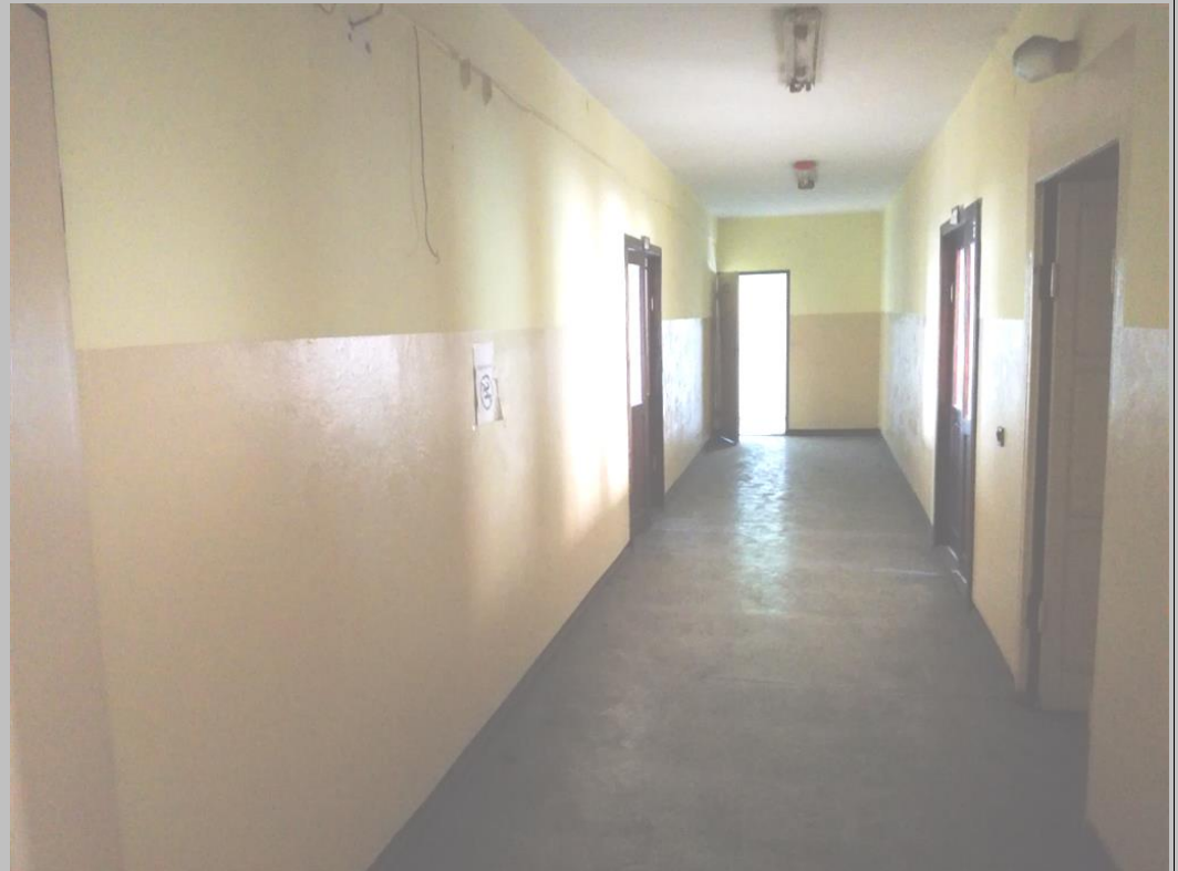
Fot.3 Korytarz 1piętra przewidziany do przebudowy
