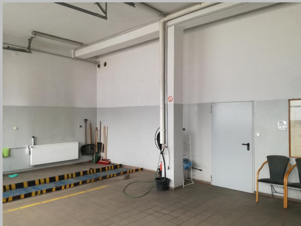
Fot. 2 Słup i podciągi podtrzymujące strop nad parterem - w miejscu projektowanej przebudowy.
