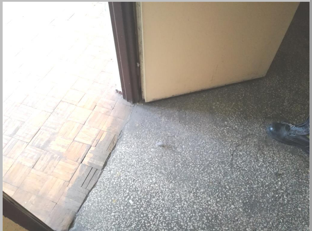
Fot.4 Posadzki pomieszczeń 1 piętra
