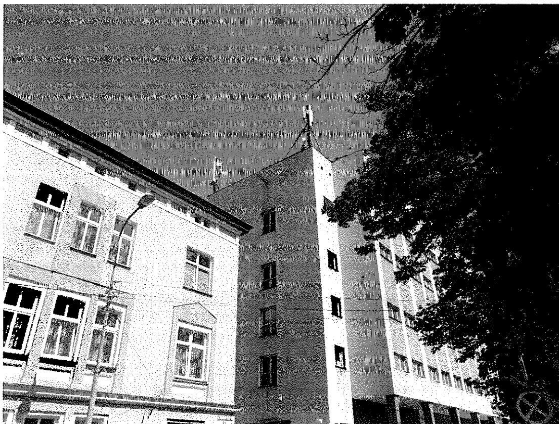
Zdjęcie 1 Badany obiekt
