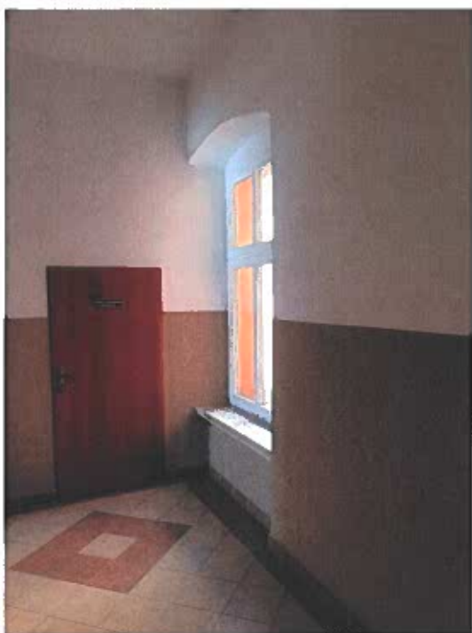
Zdjęcie nr 5 – widok na komunikację na parterze w części „B” budynku – w miejscu otworu okiennego przewidywana lokalizacja drzwi dźwigu osobowego
