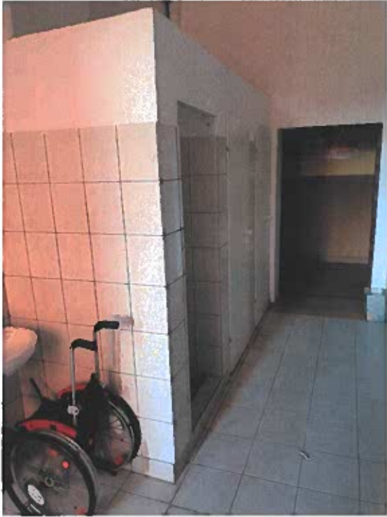
Zdjęcie nr 10 – widok na istniejącą toaletę w części „A” obiektu przeznaczoną do przebudowy
