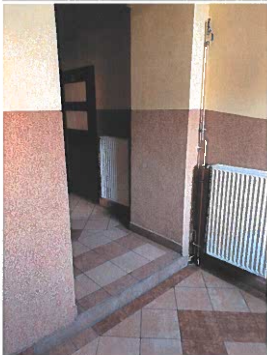
Zdjęcie nr 12 – próg w części „A” do dostosowania do komunikacji dla niepełnosprawnych
