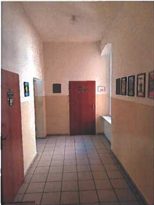
Zdjęcie nr 6 – widok na komunikację na I piętrze w części „B” budynku – w miejscu otworu okiennego przewidywana lokalizacja drzwi dźwigu osobowego
