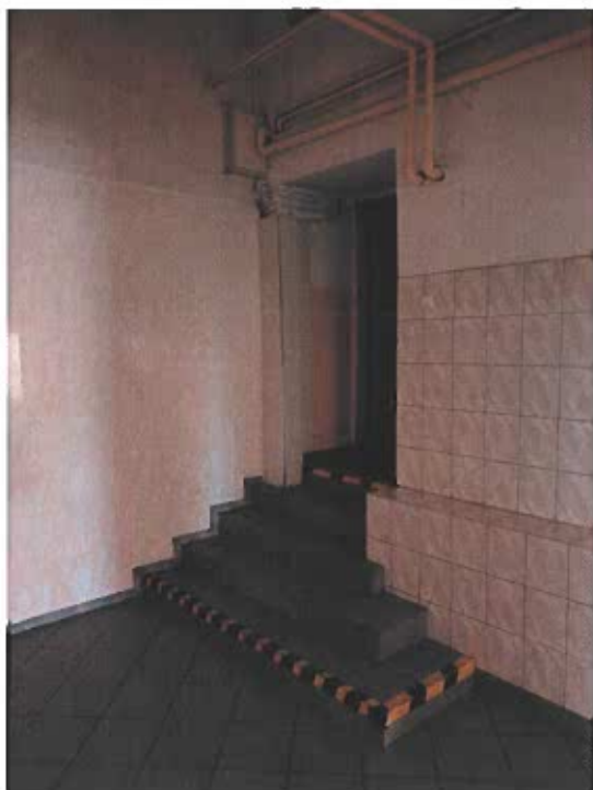
Zdjęcie nr 13 – schody do stołówki w części „B” do dostosowania do komunikacji dla niepełnosprawnych
