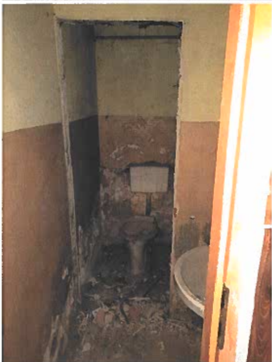
Zdjęcie nr 8 – widok na istniejące toalety w części „B” obiektu przeznaczony do przebudowy
