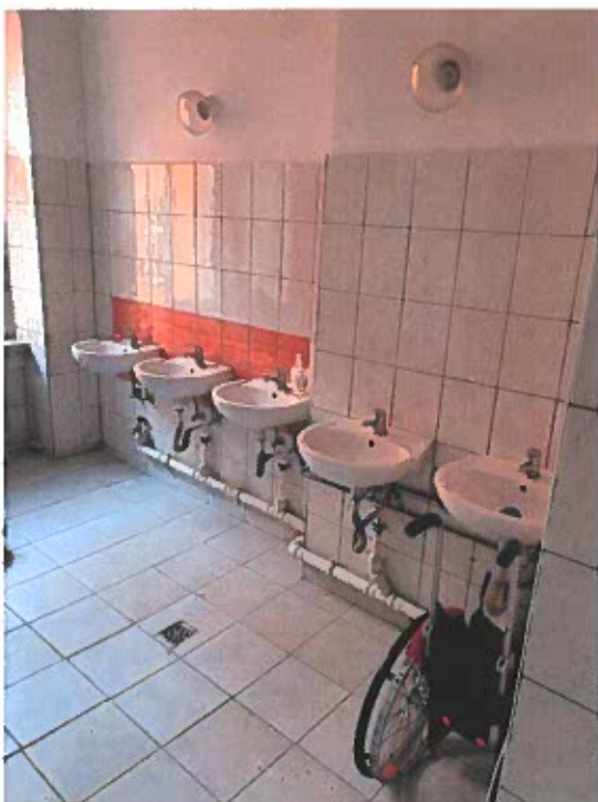
Zdjęcie nr 9 – widok na istniejącą toaletę w części „A” obiektu przeznaczoną do przebudowy
